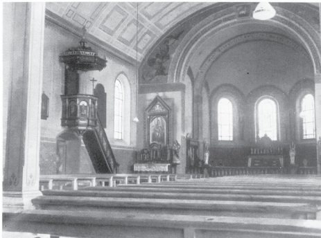
vor der Renovation 1935
